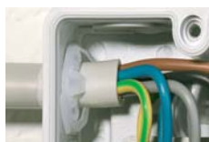
Anilhas para retenção de cabos, para alívio da tensão
