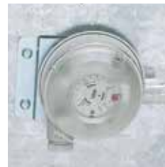
Pressostato colocado no interior da caixa.
